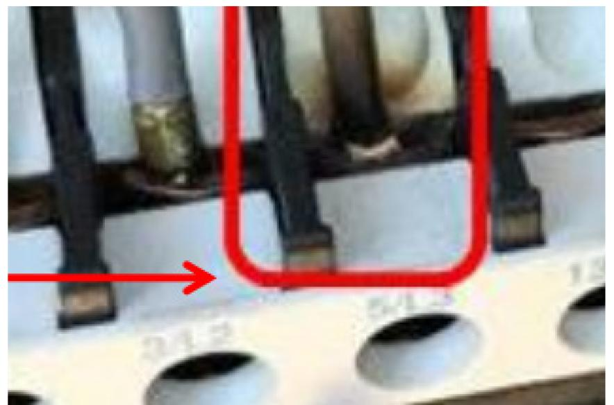
**!** Exemplo de mau contato devido à falta de reaperto em parafuso de fixação do cabo elétrico de contator, presente no painel utilizado no acionamento de uma bomba de poço artesiano.
